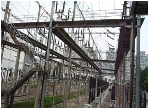
图 2 改造前 220kV 户外配电装置
